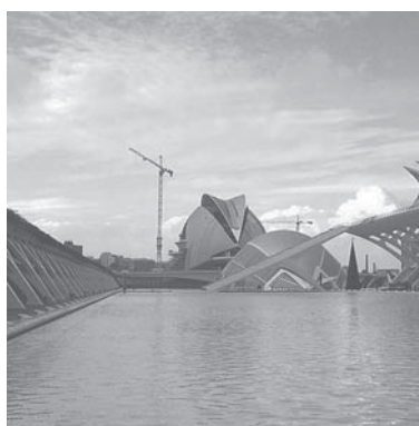
Obras en Valencia.
