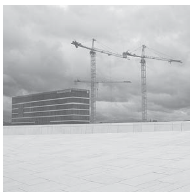
Obras en Oslo.
