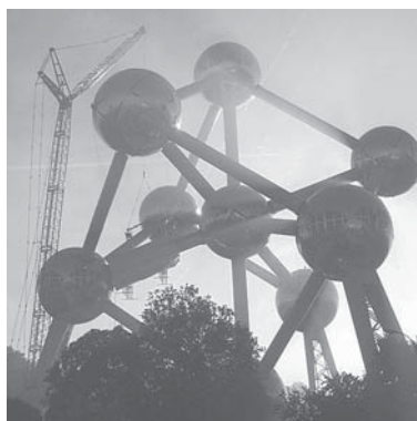
Obras en Bruselas.
