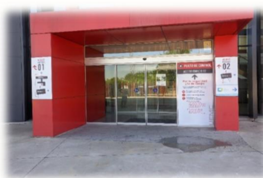
Imagen 2. Puerta de acceso edificio 02
