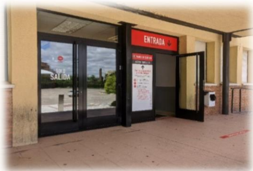
Imagen 1. Puerta de acceso edificio 01
